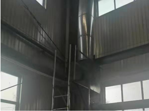
发动机试车废气吸附装置照片
