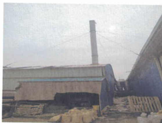
开松混料、梳理工序排气筒（有组织颗粒物）
