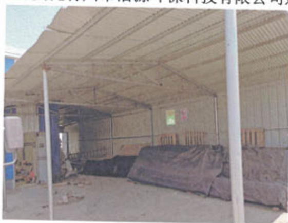
一般固废暂存场照片
